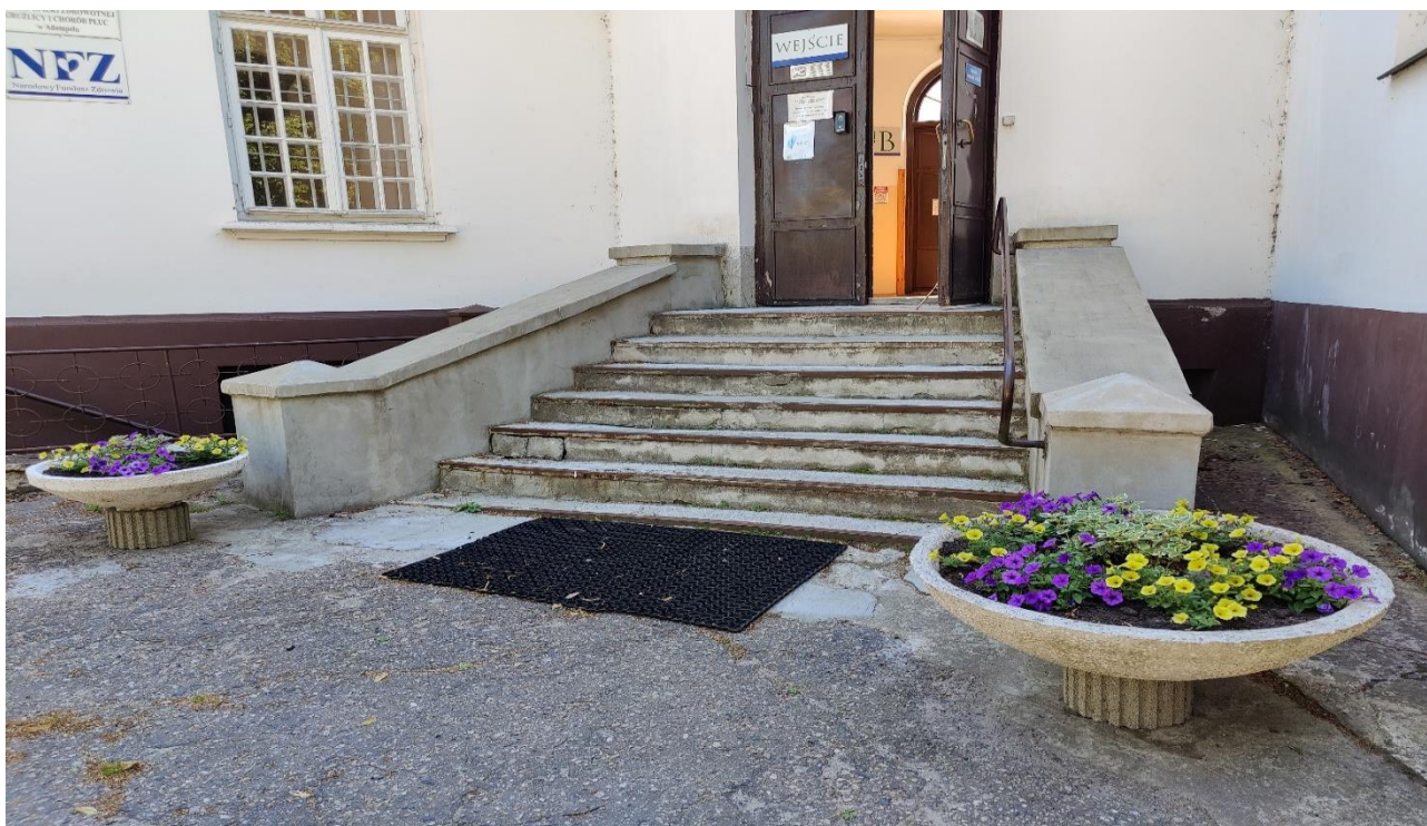
Fot. 1. Widok ogólny schodów. Widoczne uszkodzenia stopni i podstopnic wykonanych z betonu żwirowego i lastryko.
