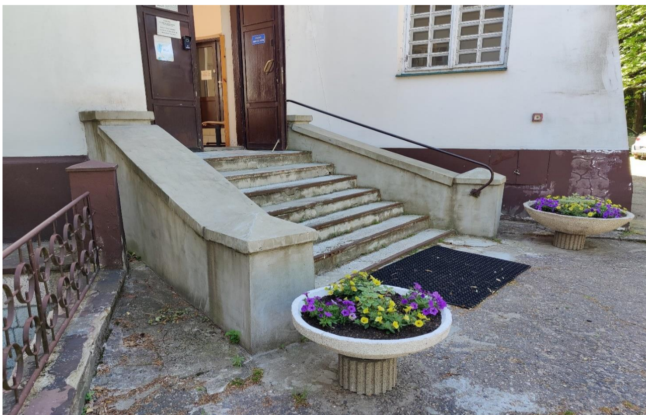
Fot. 3. Widok ogólny schodów. Widoczne uszkodzenia stopni i podstopnic wykonanych z betonu żwirowego i lastryko.
