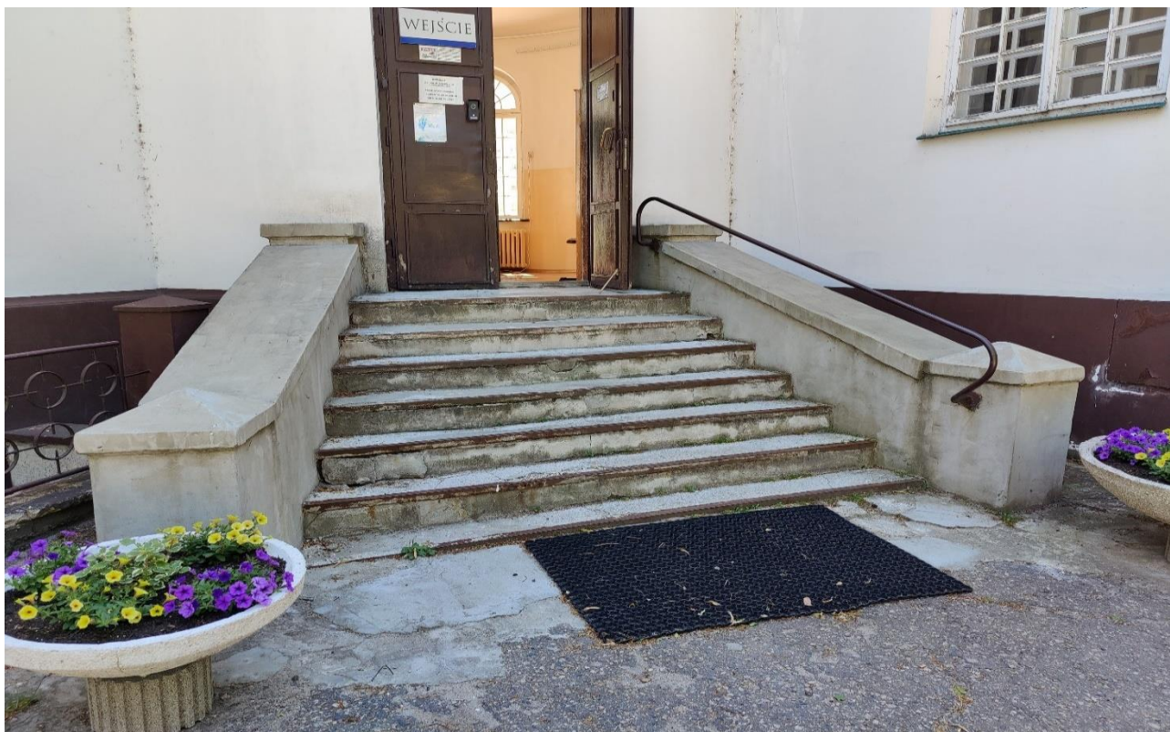
Fot. 2. Widok ogólny schodów. Widoczne uszkodzenia stopni i podstopnic wykonanych z betonu żwirowego i lastryko.
